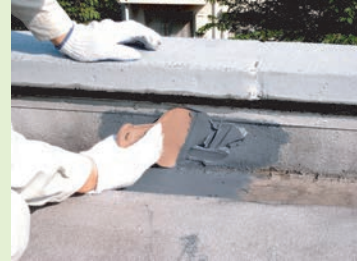
小規模防水工事
