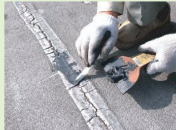
クラック補修工事
