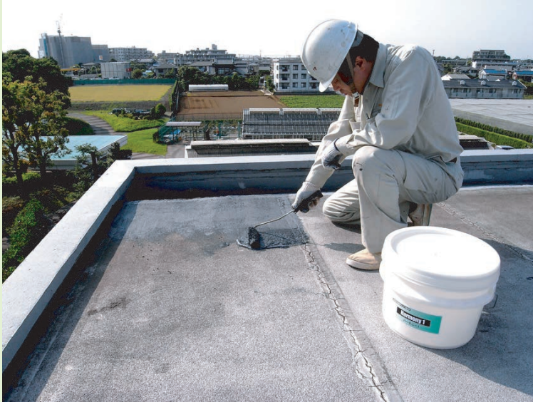
屋上防水工事
