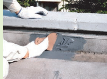
小規模防水工事
