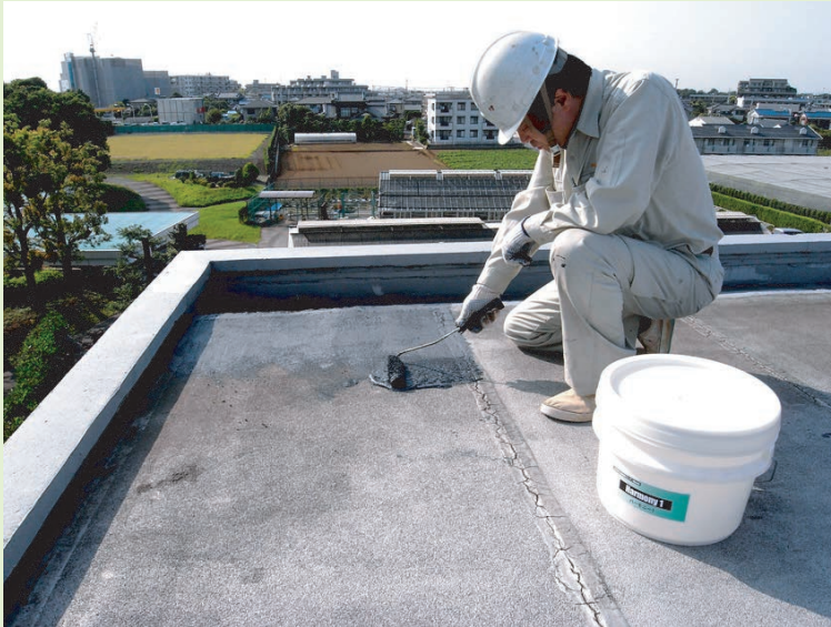
屋上防水工事
