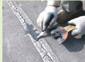
クラック補修工事
