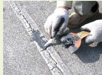
クラック補修工事
