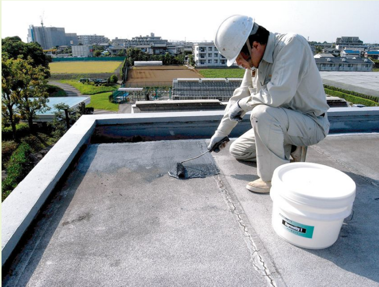
屋上防水工事
