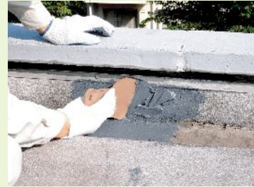
小規模防水工事
